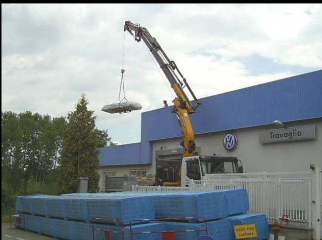
Carico pannelli sul tetto
