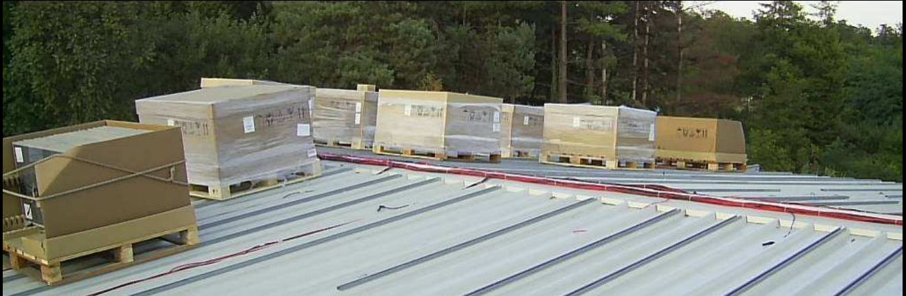
Arrivano i pannelli fotovoltaici
