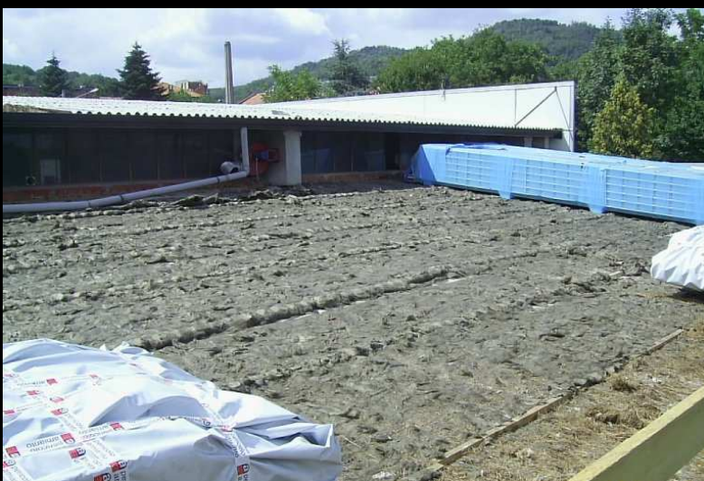
Bonifica del vecchio tetto in eternit
