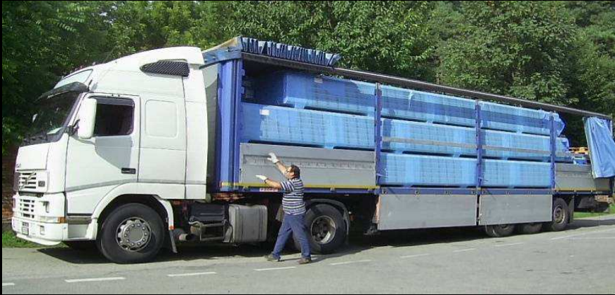
Arrivo dei pannelli tetto
