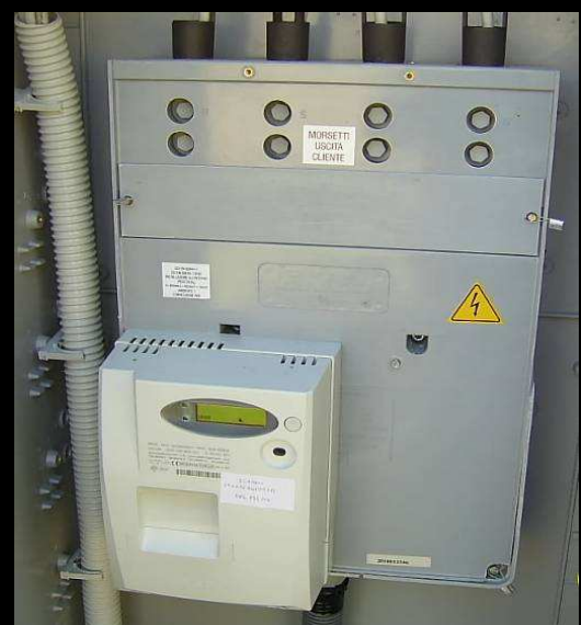
Contatore di scambio Enel
