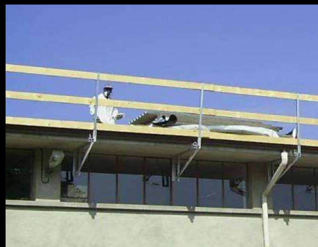
Rimozione tetto in eternit
