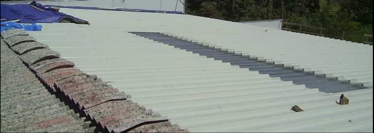
Vengono sostituite le 3 falde del tetto per un totale di 860 mq
